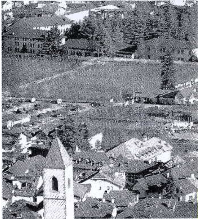
L'area tra l'ex caserma e il parcheggio Tetter dove sorgerà la nuova caserma
